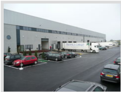
The new Nivelles site
